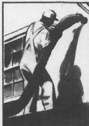
Installing loose fill
